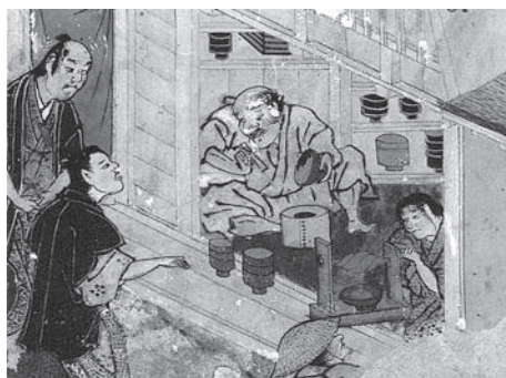
図2 舟木本洛中洛外図屏風に描かれた漆師屋工場の様子
