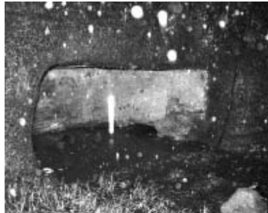
図7 冠水した大五輪やぐら（2003年8月15日撮影）
